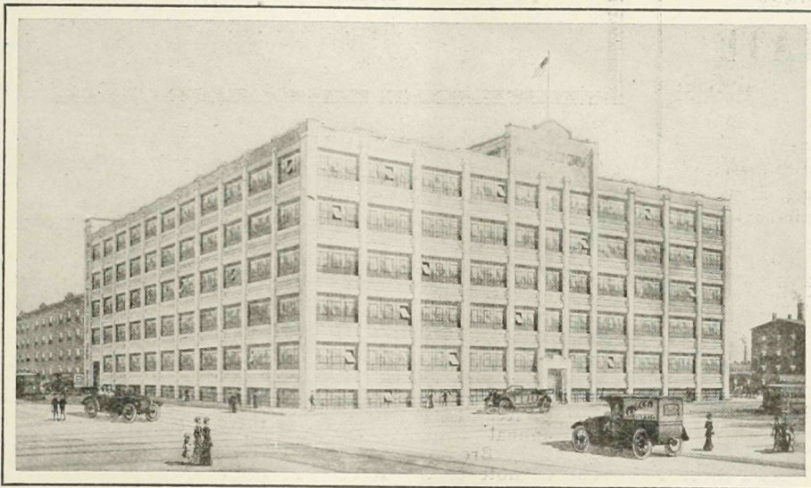
Wells Bros. Co., Builder.
